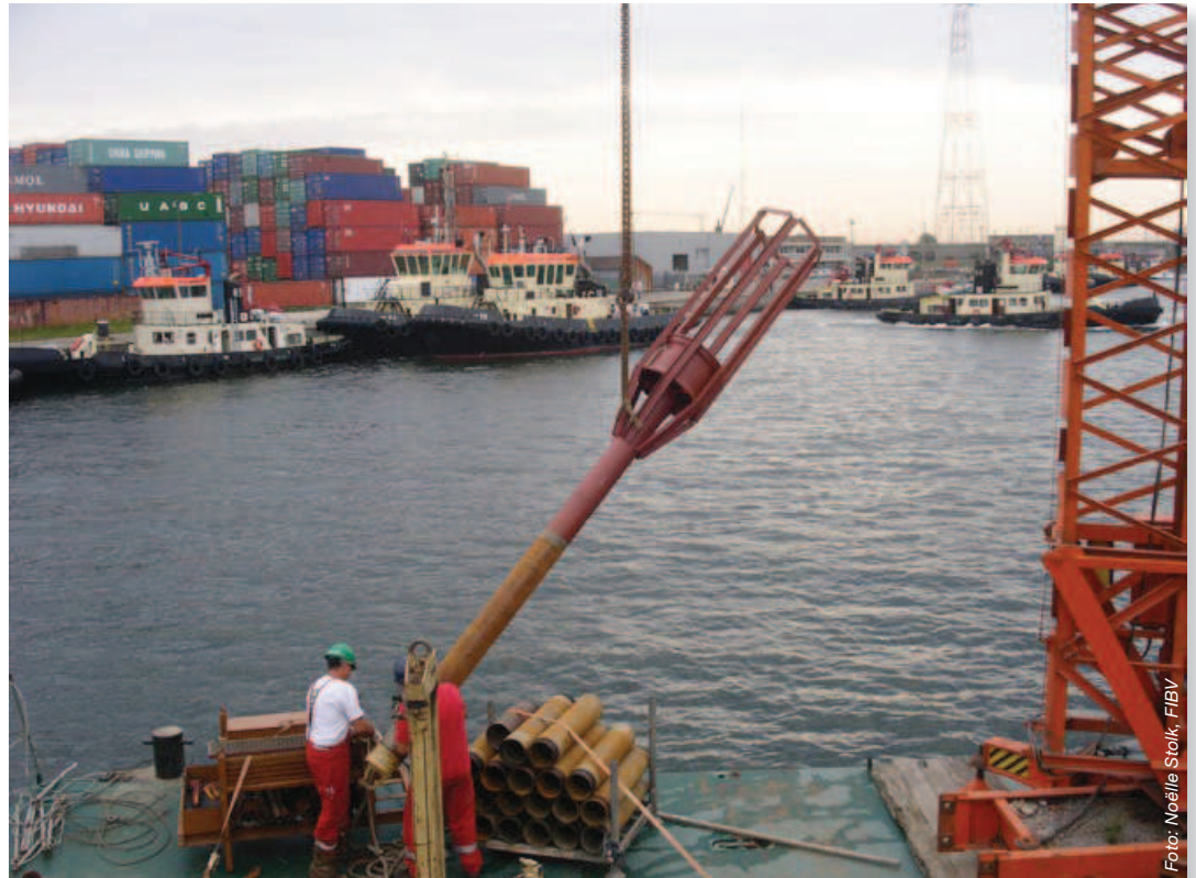
Het overboord hijsen van de korf onder aan de boorpijp in Kanaaldok 2B.
