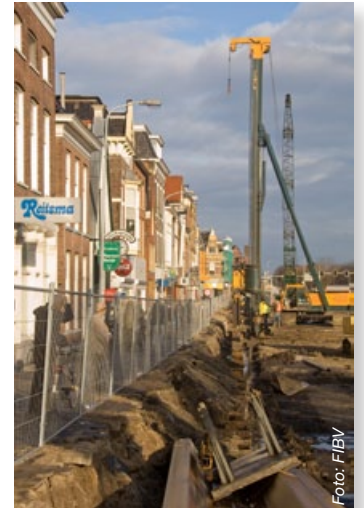
Het wegduwen van de damwand aan de noordzijde van het Damsterdiep.
