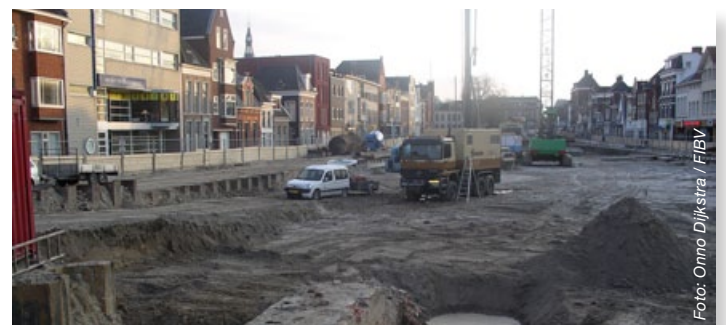
Voor het installeren van de hellingmeetbuizen gebruikte Fugro in verband met de tijdsdruk een innovatieve methode.
